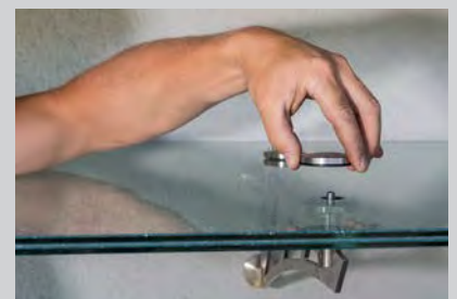
6 / Visser les caches supérieurs avec leur joint
