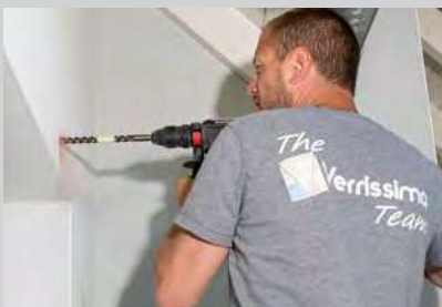
1 / Percer les trous et adapter la fixation des tiges filetées en fonction du support
